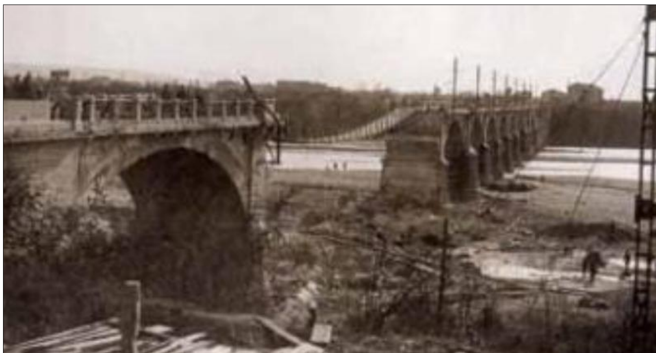
Passerella che congiungeva le arcate del ponte di Vidor, interrotto il 10.11.1917 dagli Italiani in ritirata.
