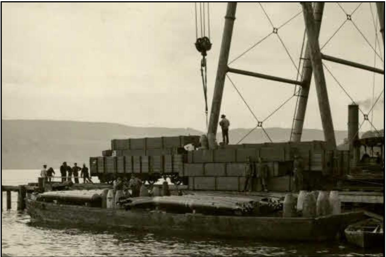
Zelenika, operazioni di scarico di siluri tedeschi BAW, https://www.archivinformationssystem.at/detail.aspx?ID=3058402
